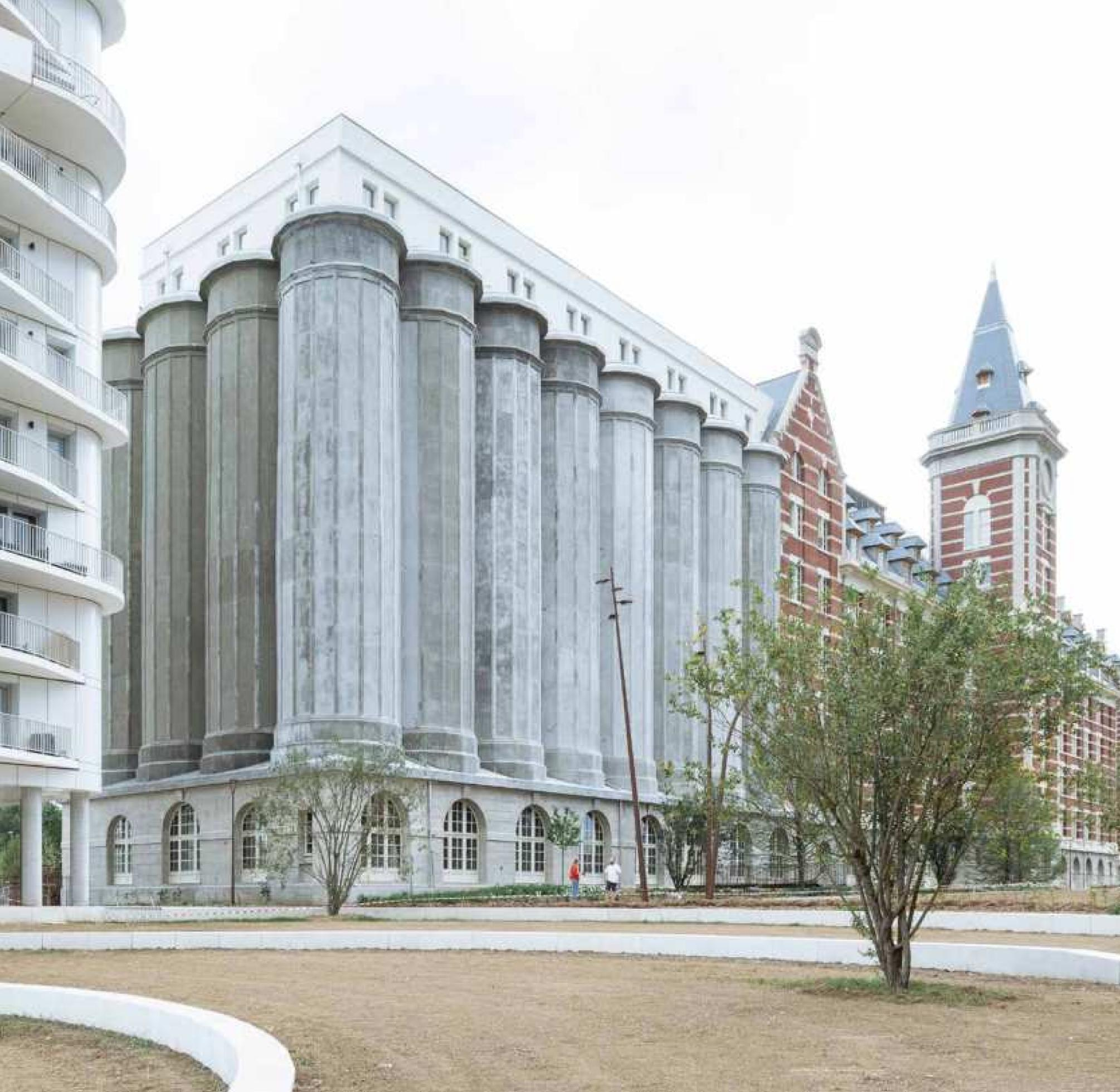
Le moulin et le magasin, reliés par la passerelle, sont restaurés, tout comme le laboratoire, la boulangerie, l'habitation ou encore la chaufferie. L'ensemble des matériaux : le béton, la brique et l'ardoise sont les témoins d'une technique constructive et d'un style. Le béton avait été employé pour la structure et la charpente, mais également pour le second œuvre et le décor. Il reste apparent, simplement peint en blanc. La brique avait permis de dresser rapidement l'édifice.
