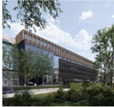
Surélévation du bâtiment principal sur 2 niveaux en structure métal et bardage bois.
