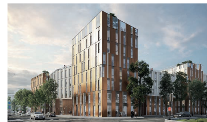
OPEN'R – construction du siège de Mobivia – Villeneuve d'Ascq (59)
