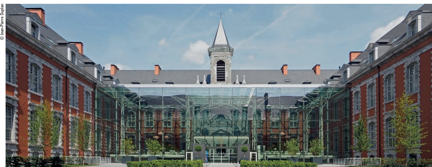
Royal Hainaut SPA & Resort hôtel – réhabilitation du Monument Historique – Valenciennes (59)
