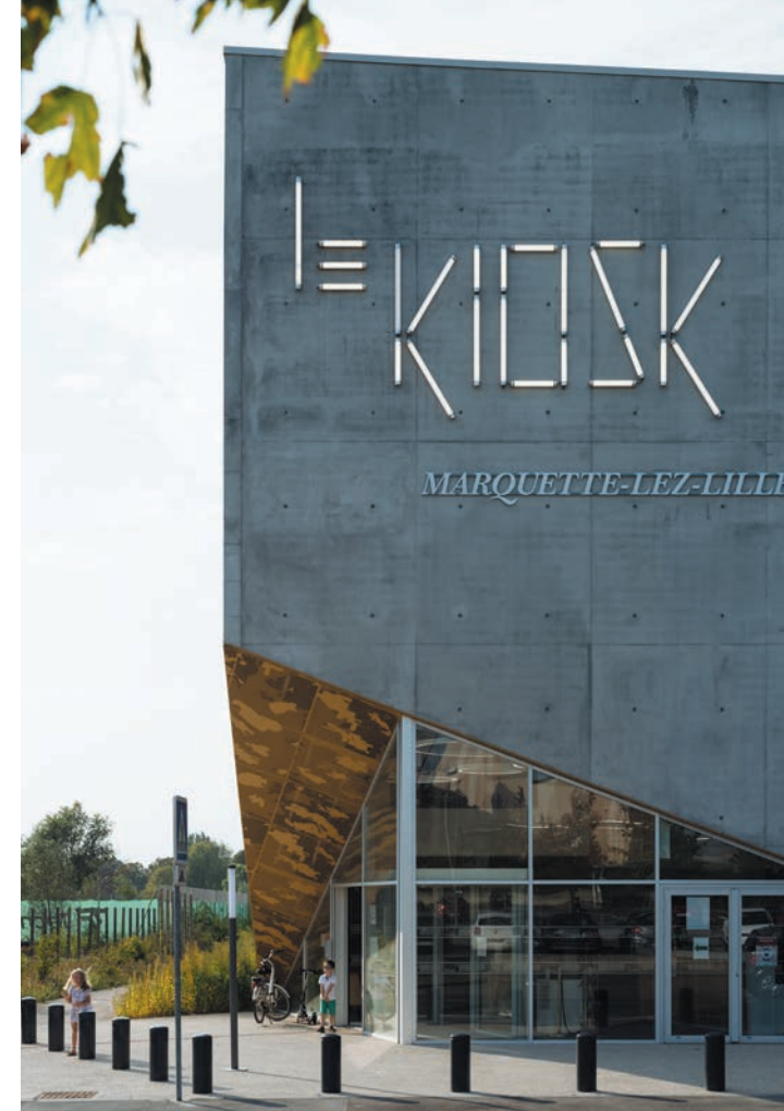
Le Kiosk – construction de la salle polyvalente – Marquette-lez-Lille (59)
