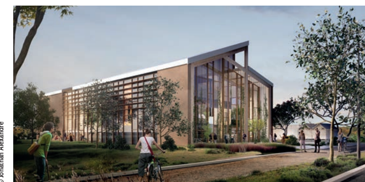
La Passerelle – éco-construction d'un espace de co-working – Ennevelin (59)
