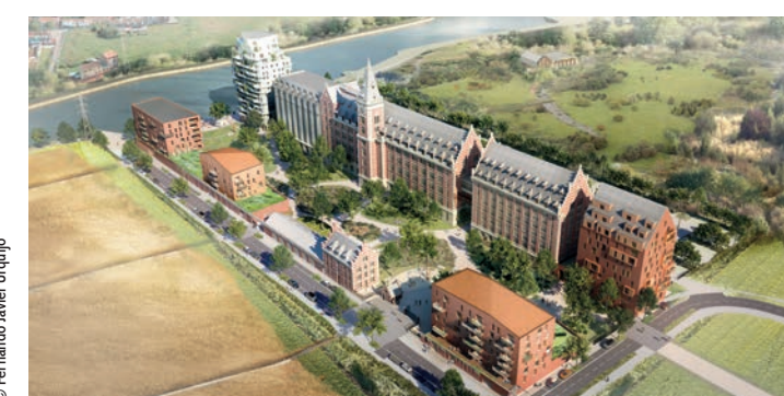
Les Grands Moulins de Paris – réhabilitation des Monuments Historiques – Marquette-lez-Lille (59)
